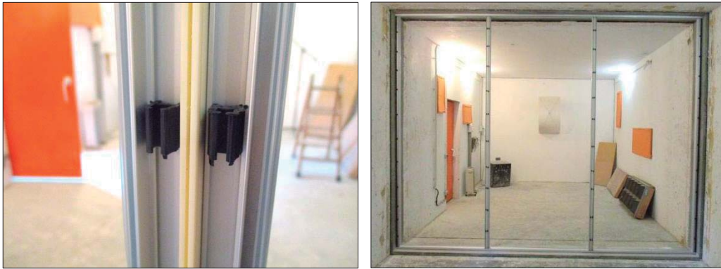
Imágenes 11 y 12 Montaje de la estructura de soporte
