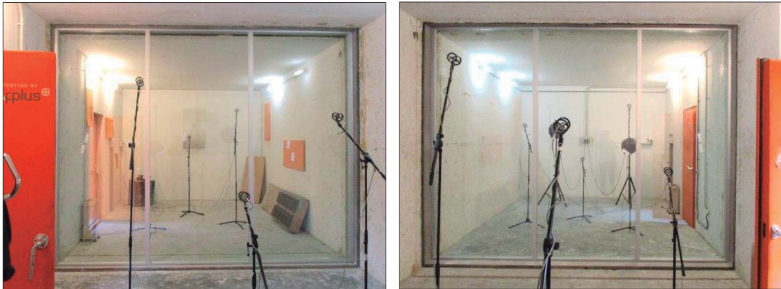
Imágenes 17 y 18 Cerramiento interior MAMPARA DINOR VIDRIADA
